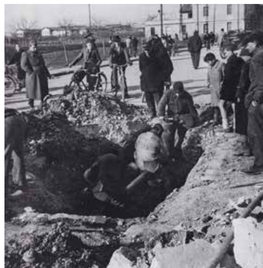
Figura 16 - Via Cremona, riparazione rete gas (ASBs, fondo UNPA, b.74).
