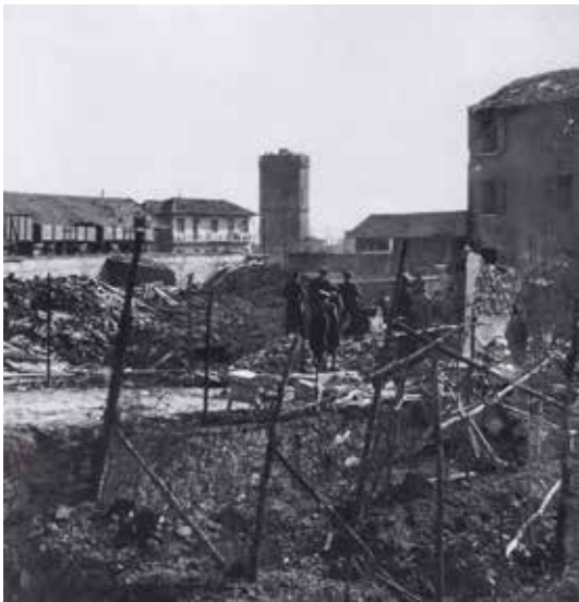
Figura 18 - Via Sostegno, abitazioni distrutte (ASBs, fondo UNPA, b.74).
